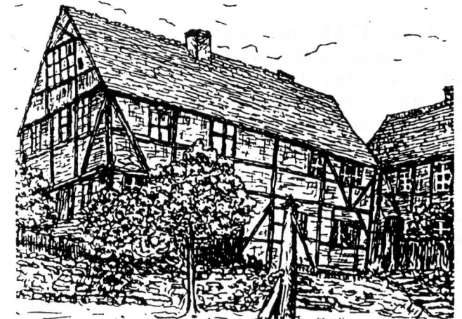
Das älteste noch stehende Haus Oderbergs auf dem Oberkietz aus dem Jahre 1680
